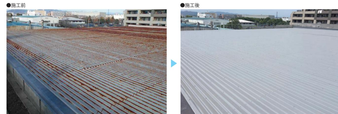
雨風にさらされ経年劣化により、屋根全体がサビってしまった倉庫の屋上。塗膜やコーキングの劣化、亀裂などの原因による雨漏りも発生。
